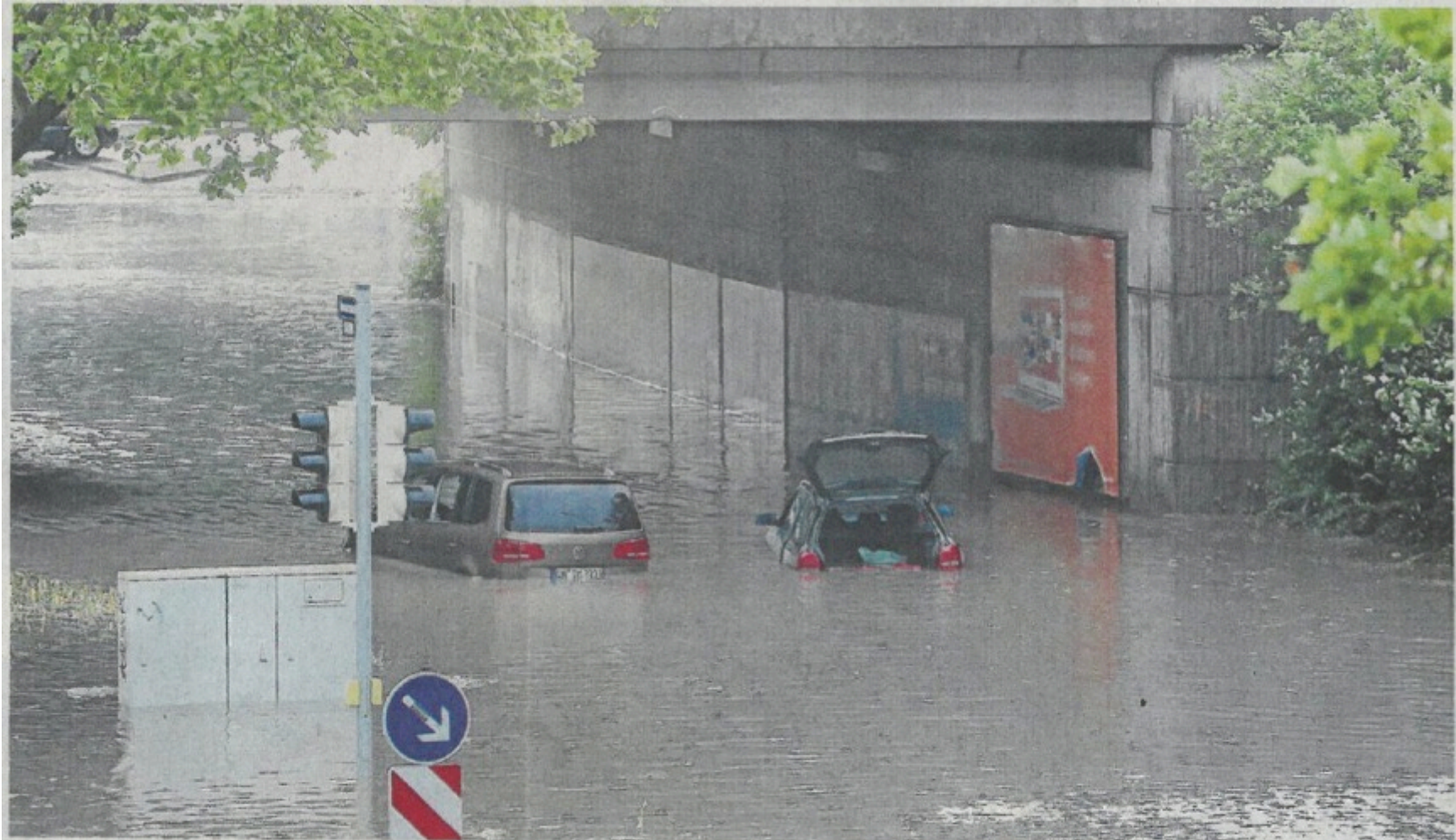
Es muss kein Jahrhundertregen fallen: Auch starke Gewitter, hier ein Foto vom 20. Juni 2013, sorgten in der Vergangenheit an der Bahnunterführung im Bereich Borussiastraße / Steinhammerstraße für starke Überflutungen.
